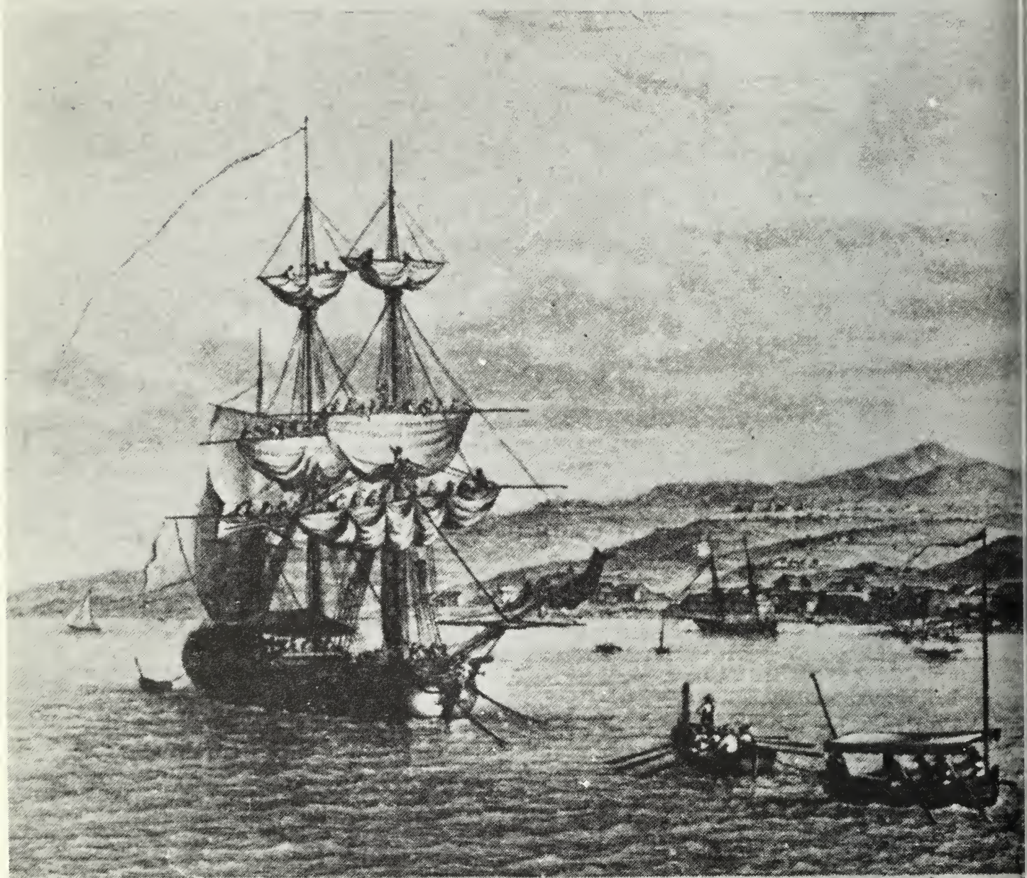
LA VILLE DE LA BASSE TERRE Vue du
